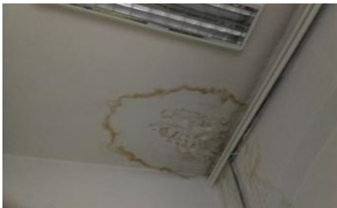
Zatékání do stropu z koupelny v bytě v 2.NP
