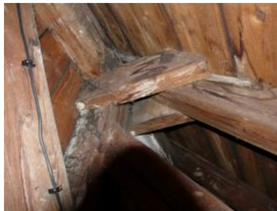
Spoj plné vazby krovu ve střední části
